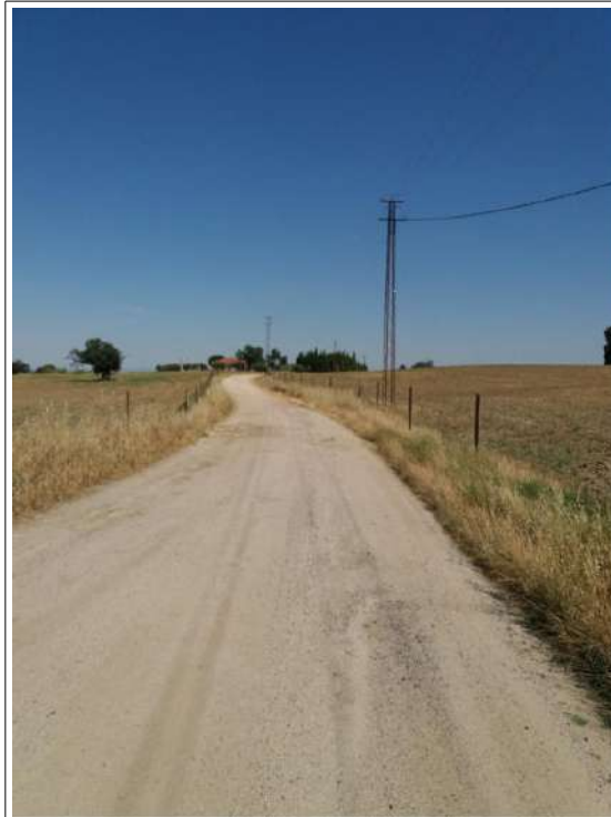
Estado del camino en PK1+005
